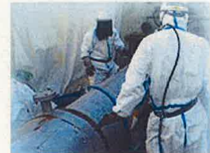
焼却炉の解体の様子
