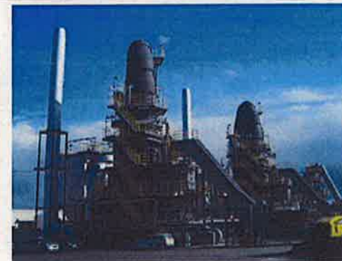
仮設焼却炉(平成25年2月、相馬市)
