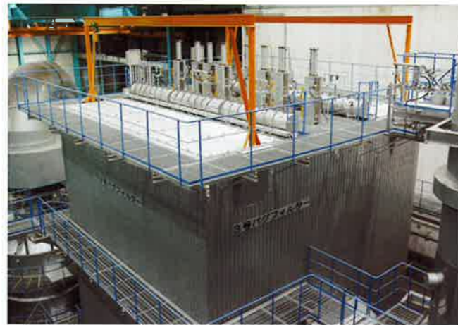
ろ過式集じん器 (バグフィルター) ばいじんと共にダイオキシン類等の有害物質をろ過し、除去します
