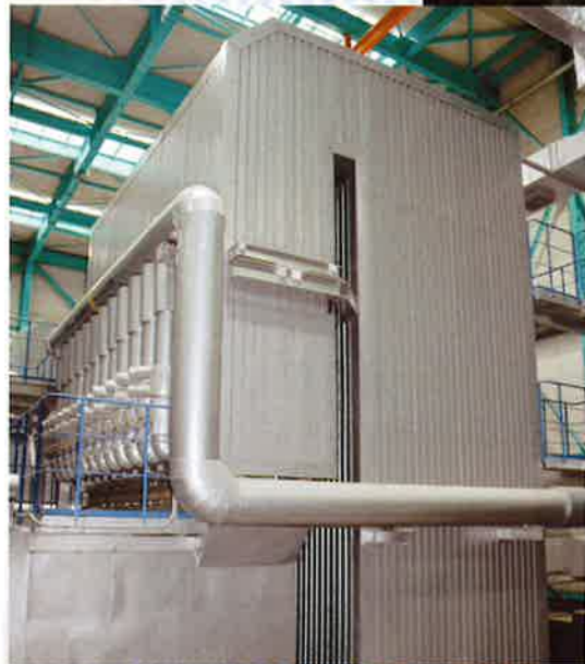
触媒反応塔 アンモニアと窒素酸化物を触媒反応させることにより、無害な窒素と水に分解します
