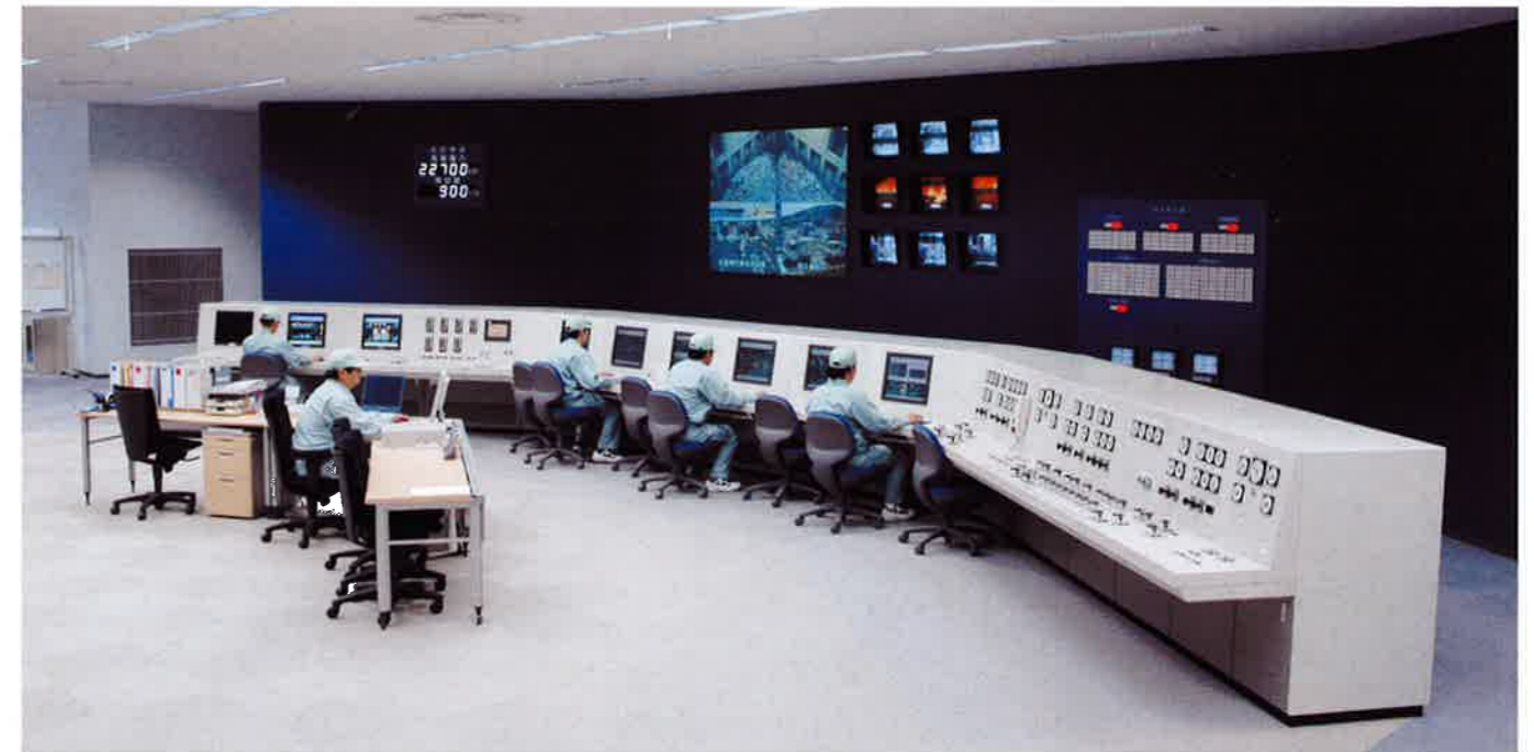
中央制御室 工場全体のすべての機器の運転状況を集中監視し、遠隔操作で的確な運転を行います
