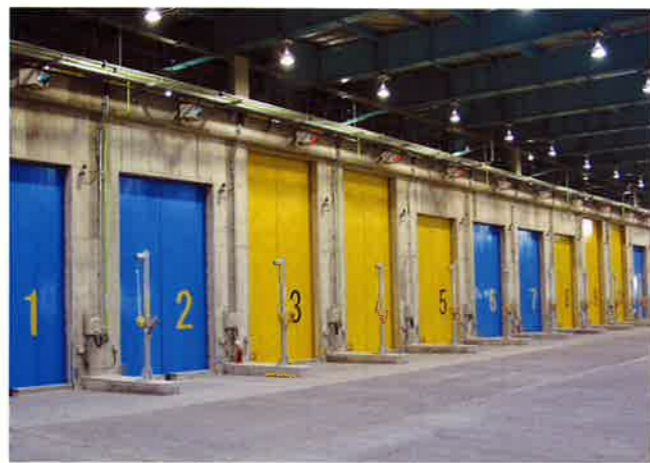
プラットフォーム 自動開閉式の投入扉からごみは投入されます
