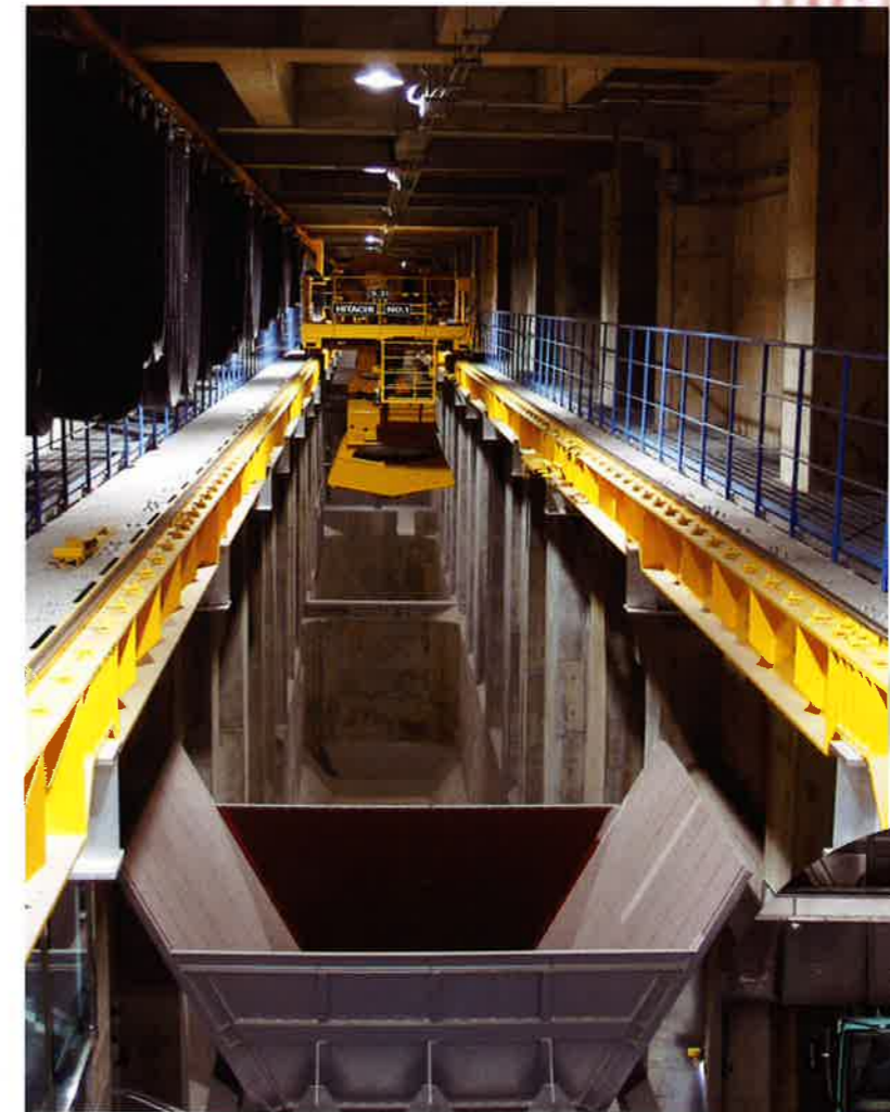
灰クレーン・灰ピット このクレーンは、自動で灰の積込を行います
