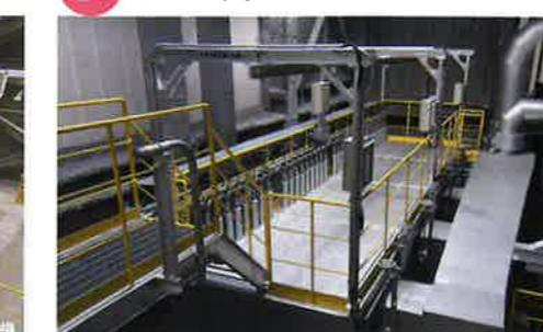
ろ過式集じん器では、排ガスに消石灰と活性炭を吹き込み、化学反応させて、ダイオキシン類、塩化水素、硫黄酸化物、水銀などの有害物質をろ過するフィルタで集めます。
