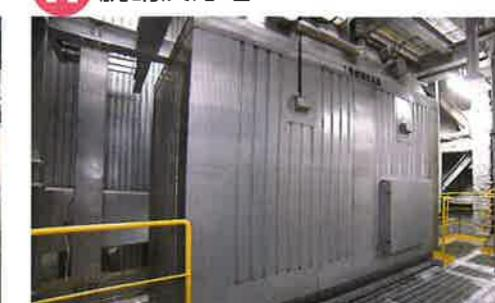
脱硝反応塔では、排ガスに気化させたアンモニア水を吹きかけて触媒を通することで、窒素酸化物を環境に影響のない窒素と水に分解することで除去しています。
