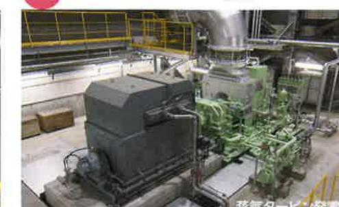
ごみを燃やして発生した熱をボイラに送り、水を加熱して高圧蒸気を発生させます。蒸気タービンの羽根を高圧蒸気で回し、発電機を動かして発電します。定格発電量は5,190kWです。
