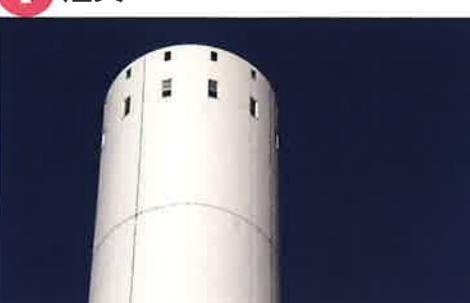
ろ過式集じん器や脱硝反応塔で処理された排ガスは、高さ85mの煙突から排出されます。排ガスに含まれる有害物質濃度は、全国トップレベルの厳しい基準値をクリアしています。
