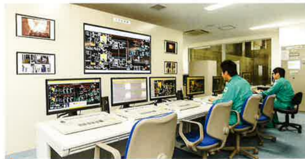
中央制御室 施設全体の設備や運転状況を監視・操作する場所です。24時間体制で集中管理し、安全・確かな運転を行います。
