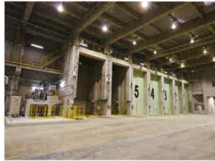
プラットフォーム 入口扉を二重とし、出口には扉と共にエアカーテンを設け、臭気が外部へ漏れるのを防いでいます。
