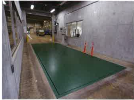
入口計量機 収集されたごみを入場時に自動的に計量・記録し、集中管理します。
