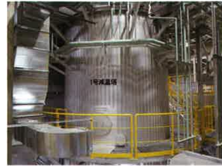
減温塔 排ガスを再利用水で急冷します。又、苛性ソーダを吹き込むことで排ガス中に含まれる塩化水素等を取り除きます。
