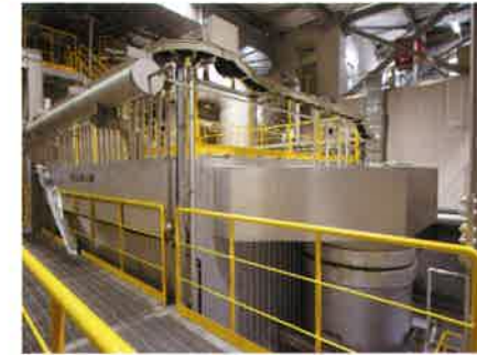
ろ過式集じん器 消石灰や活性炭を吹き込んだ排ガスをろ過し、排ガス中に含まれる硫酸化合物、塩化水素等の有害成分を飛灰(ダスト)と共に取り除きます。
