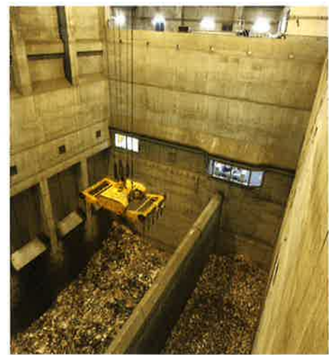
ごみピット・ごみクレーン ごみピットは受入ごみピットと破碎ごみピットがあり、ごみクレーンで受入ごみ投入ホッパ及び破碎ごみ投入ホッパに投入します。
