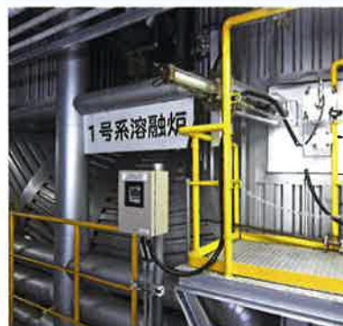
溶融炉 約1250℃の高熱で灰分を溶融し、減容化及び無害化を図ります。
