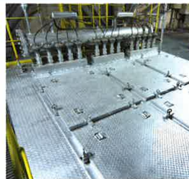
バグフィルタ 排ガス中のばいじんと有害物質は、この装置により取り除きます。
