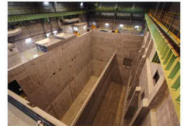
③ ごみビット ごみビットに貯められたごみは、ごみクレーンによりごみホッパへ投入します。
