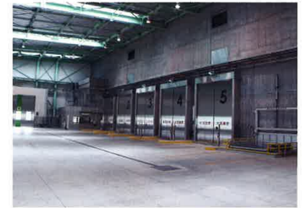
② プラットホーム 運び込まれたごみは、ごみ投入扉を通してごみビットに投入されます。
