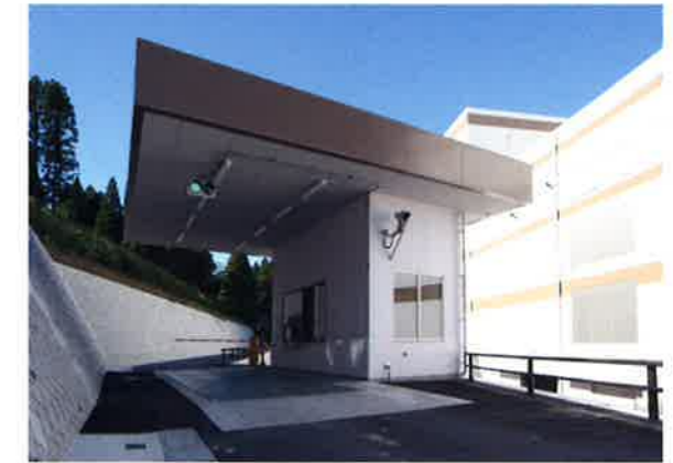
① 計量機 収集されたごみを入場時に自動的に計量・記録し、集中管理します。
