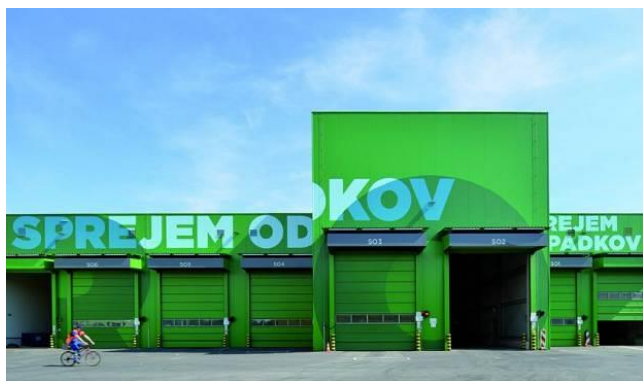
分別残りごみの搬入口
