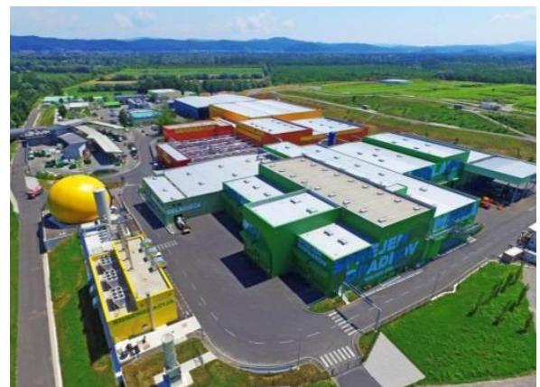
RCERO リュブリャナ（MBT 施設）
