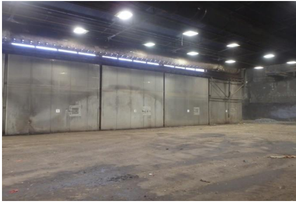
図 10. バイオトンネル (外観)
