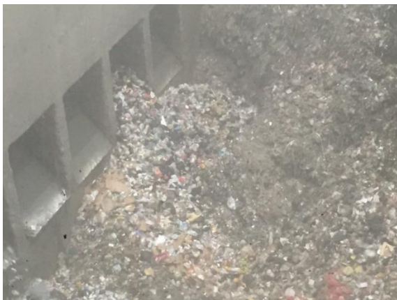
ごみピットの様子
