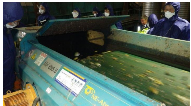
MBT 施設 現場視察 (アルミ選別機)
