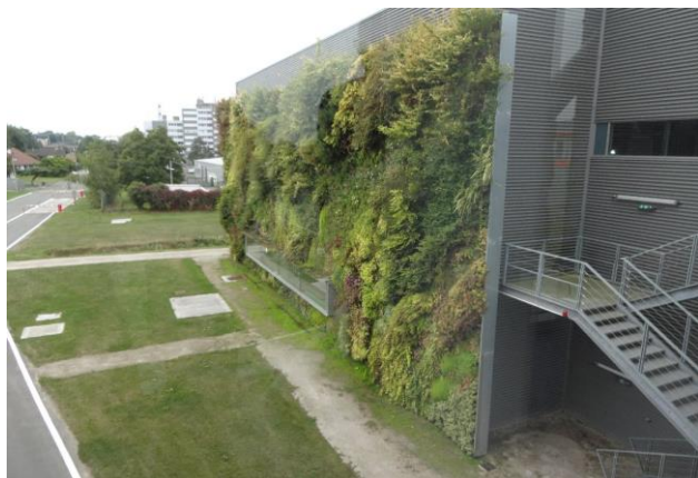
植栽した外壁
