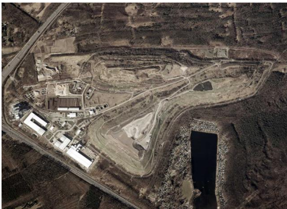
MBT 施設と埋立地の全景写真
