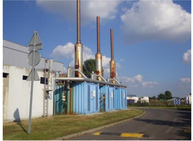
ガス発電設備（1MWh×3 基）
