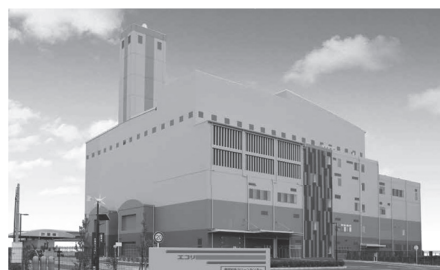
写真 施設外観
