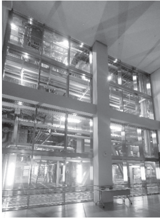
写真2 見学者通路(炉室)
