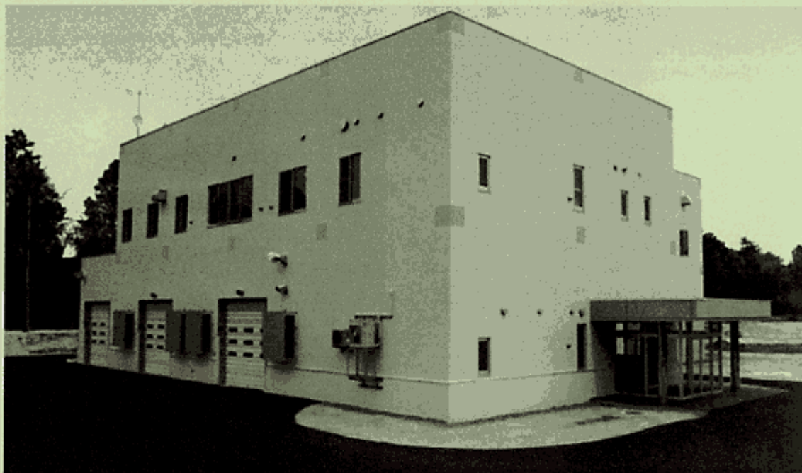
北空知衛生センター生ごみバイオガス化施設全景
