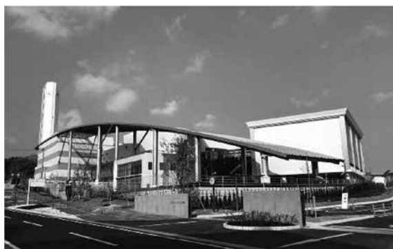
図2 今治市クリーンセンター外観
