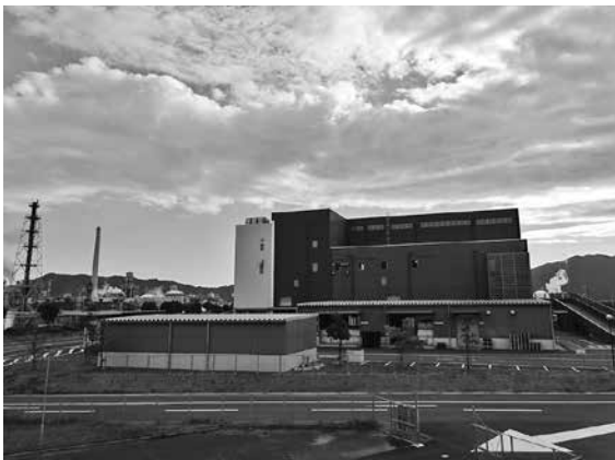
周南市リサイクルプラザ全景 (後は周南コンビナート群)
