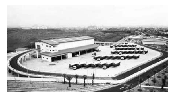
図7 インドネシア・ジャカルタごみ中継施設
